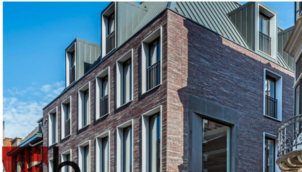
Betonnen detail rondom kozijn verwijst naar de historische wit geschilderde kozijnen
