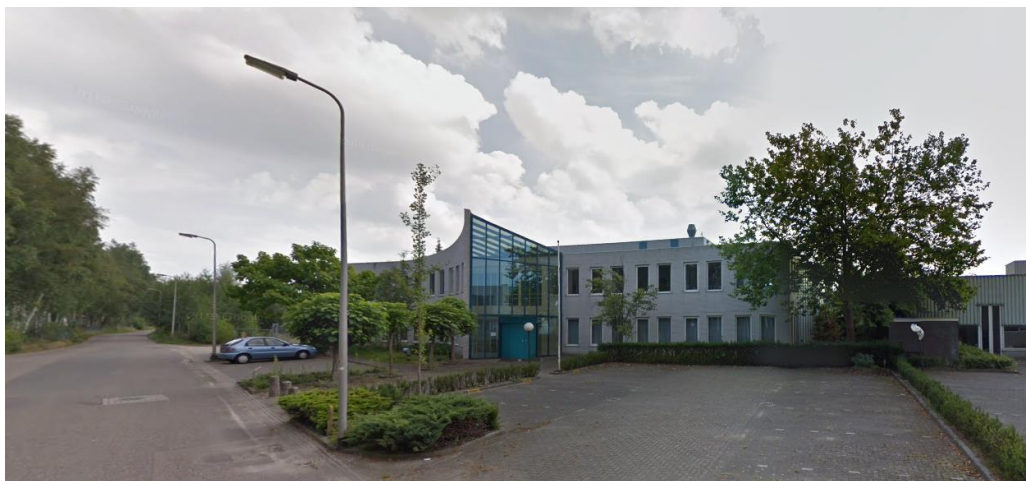
Parallelstraat aan de noordelijke kant van het plangebied: kantoorgebouw aan de rechterkant, spoorweg achter de bomen aan de linkerkant (bron: Google Maps)
