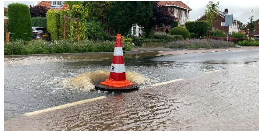
Figuur 3-4 Putdeksel komt omhoog na hevige neerslag
