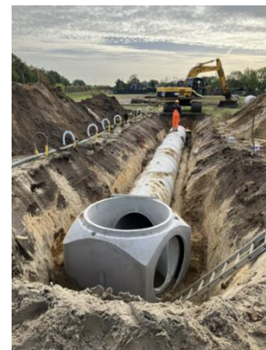
Figuur 3-2 Aanleg riolering Hyacinthstraat
