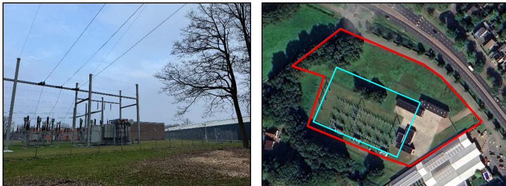
Figuur 2.5. Ten tijde van het terreinbezoek is mogelijk geschikt broedbiotoop tussen de ruimtes van de transformatoren waargenomen (links) in het plangebied (rechts). Bronnen Antea Group, 2025 en QGIS, PDOK Services, 2025.
