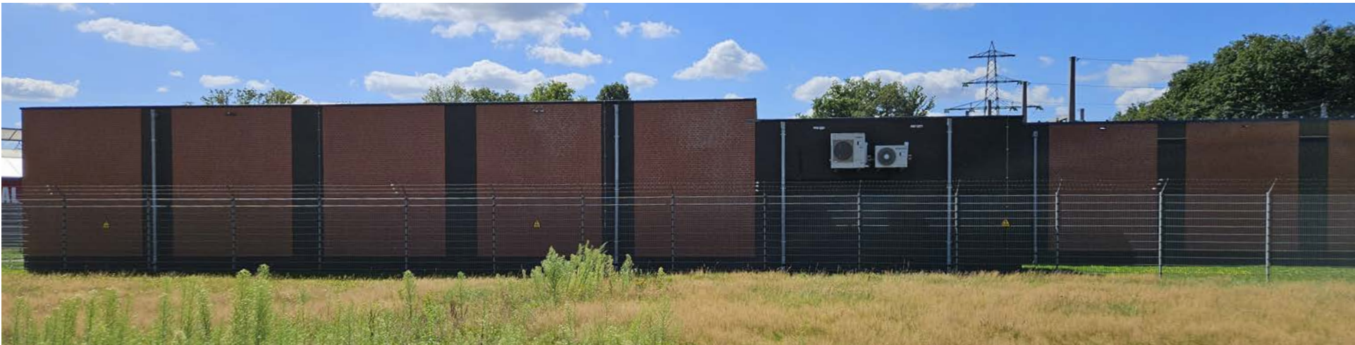
Bestaande gevel middenspanningsgebouw met zwart-antracieten en rood-oranje banen
