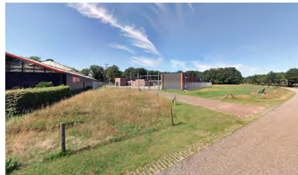
Entree hoogspanningsstation Oldenzaal via de Inslagstraat
